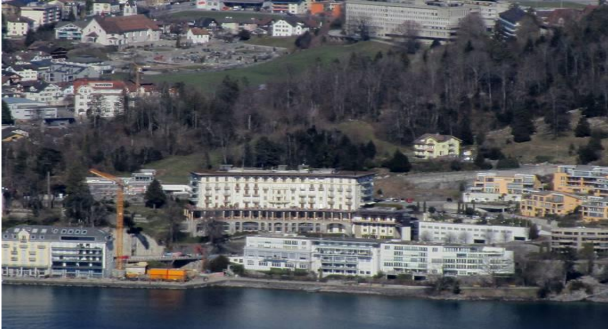
Die monströsen Betonkonstruktionen um das «Grand Hotel Brunnen» (Aufnahme Margrit Auf der Maur)
